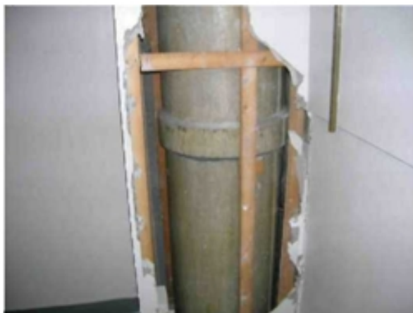
Rys. 5. Azbestowo-cementowy kanał
