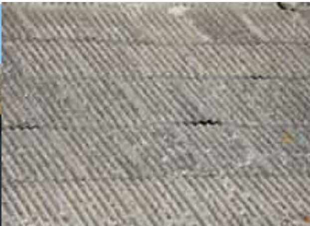
Rys. 4. Płyty faliste - eternit
