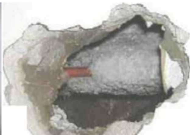
Rys. 6. Azbestowa izolacja rury
