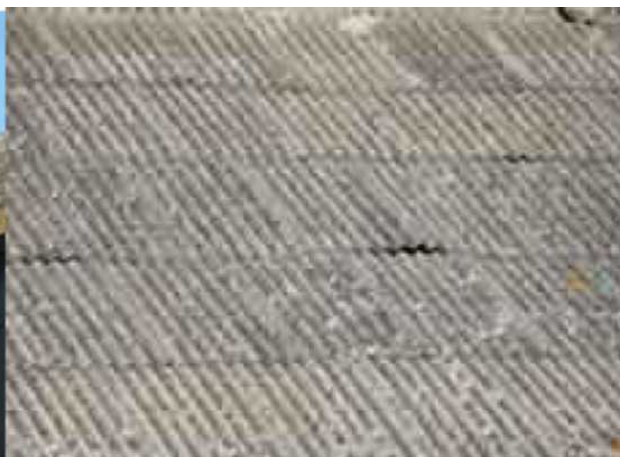
Rys. 4. Płyty faliste - eternit
