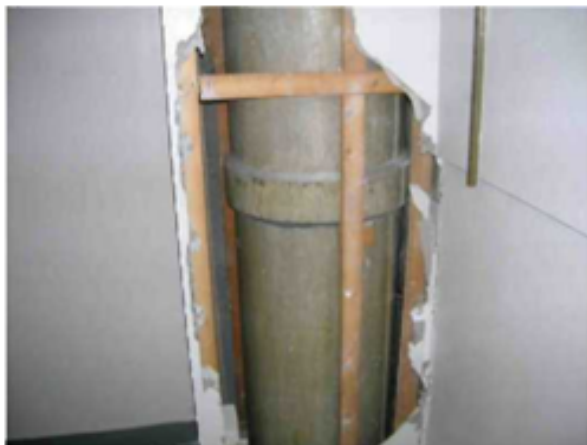
Rys. 5. Azbestowo-cementowy kanał dymowy z obudową z płyty azbestowej
