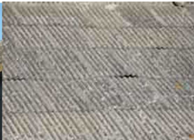
Rys. 4. Płyty faliste - eternit
