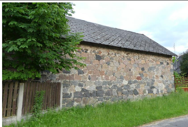
Fot. 28. Poręby nr 39, ciekawie wyeksponowana ściana zachodnia obory, mozaika kamienia i piaskowca. St. nr 6, Ryc. 7.
