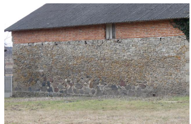
Fot. 31. Bardzo ładny układ wielu materiałów użytych do budowy miejscowej obory - głązy i kamienie polodowcowe, piaskowiec miejscowy, cegła. Poręby. St. nr 12, Ryc. 6.
