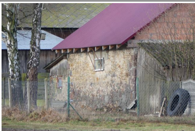
Fot. 33. Przykład łączenia różnych kamieni i skał. Poręby. St. nr 15, Ryc. 6.
