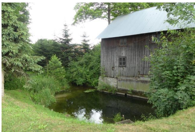
Fot. 12. Piaskowcowa podwalina starego młyna w Młyńczysku. St. 11, Ryc. 3.
