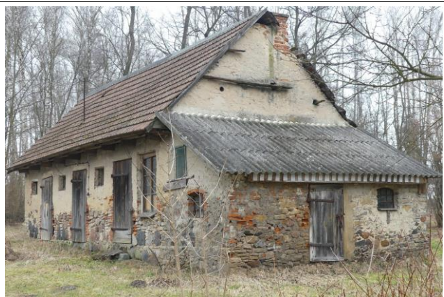
Fot. 7 Bardzo ładny, stary budynek gospodarczy na tzw. "Migówce" koło klasztoru. Lokalny ochrowy piaskowiec w mieszance z granitami polodowcowymi. Konieczna renowacja i wyeksponowanie. St. nr 2. Ryc. 2.
