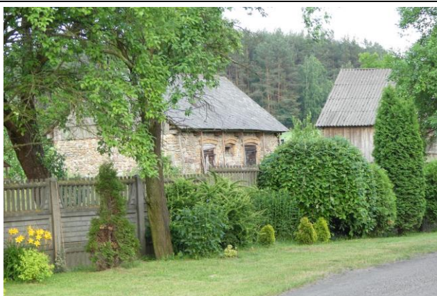
Fot. 29. Bardzo ładna obórka z lokalnie kopanego piaskowca z domieszką kamieni polnych. Poręby. St. 8, Ryc. 6.
