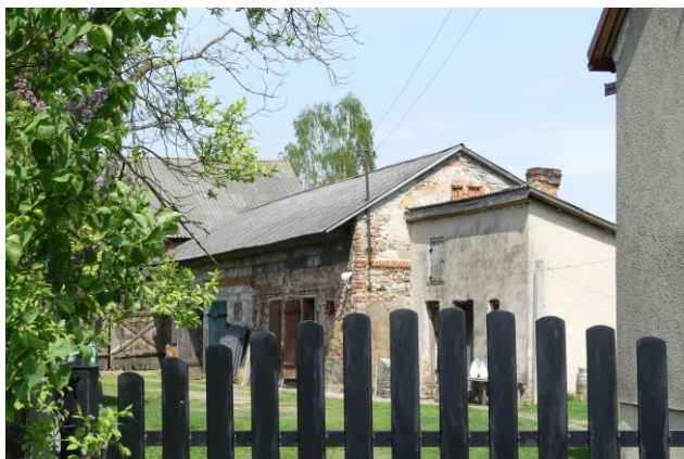
Fot. 56. Przykład wykorzystania miejscowego piaskowca żelazistego.
