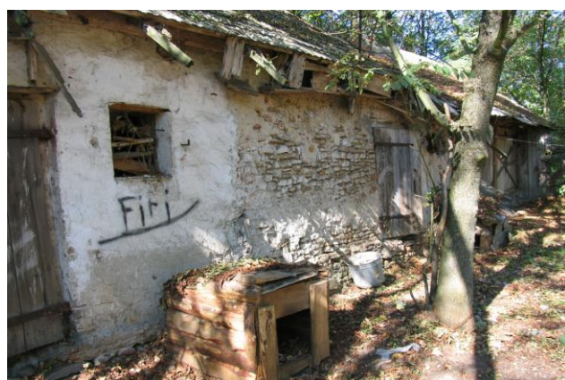
Fot. 32. Stary "klimatyczny" budynek gospodarczy. Materiał - miejscowy piaskowiec.. Poręby, st. nr 13, Ryc. 6.
