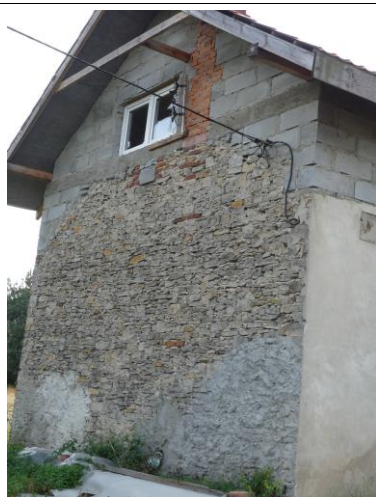
Fot. 8. Dawny budynek mieszkalny przy kościele św. Józefa. Miejscowy ochrowy kamień z Kamieńca (Poręby). St. nr 6, Ryc. 2.
