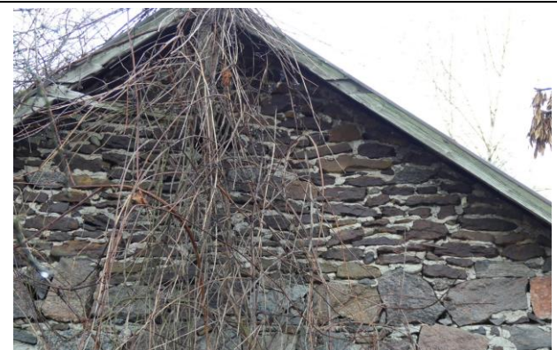
Fot. 16. Niespotykany na południowym Mazowszu przypadek wykorzystania do lokalnego budownictwa miejscowych rud żelaza. St. nr 8, Ryc. 3.
