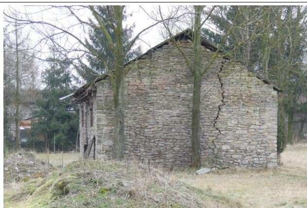
Fot. 26. Opuszczony gospodarczy budynek kamienny, piaskowiec aaleński (miejscowy!). Stuzianna, St. nr 3, Ryc. 6.
