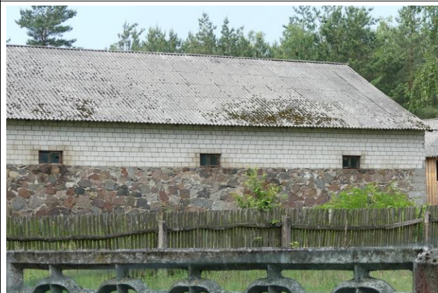
Fot. 3. Wólka Kuligowska - połączenie tradycyjnego sposobu budownictwa "skalnego" z nowymi materiałami.
