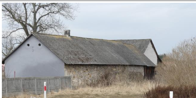
Fot. 6. Kamienna obórka, rzadki kamień piaskowcowy pozyskiwany z przysiółka Kamieniec w Porębach. St. nr 1, Ryc. 2
