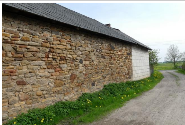
Fot. 67. Bardzo ładny budynek gospodarczy, przy lokalnej drodze, dobrze wyeksponowany. Piaskowiec żarnowski i inowłodzki. St. nr 10, Ryc. 12.
