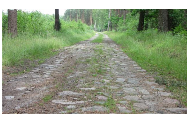
Fot. 23. Dawne kształtowanie nawierzchni dróg - kocimi łbami (bruk). Ceteń. St. nr 6, Ryc. 5.
