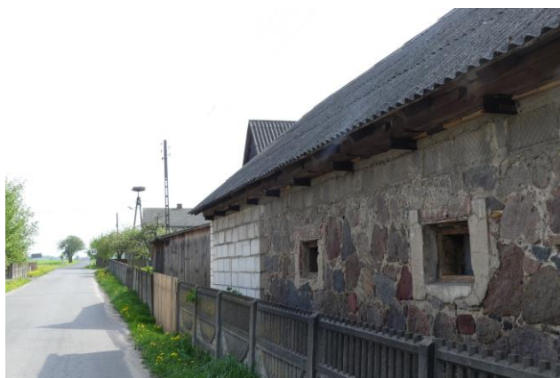
Fot. 63. Użycie gładów polodowcowych do miejscowego budownictwa. Stanowisko nr 9, Ryc. 12.
