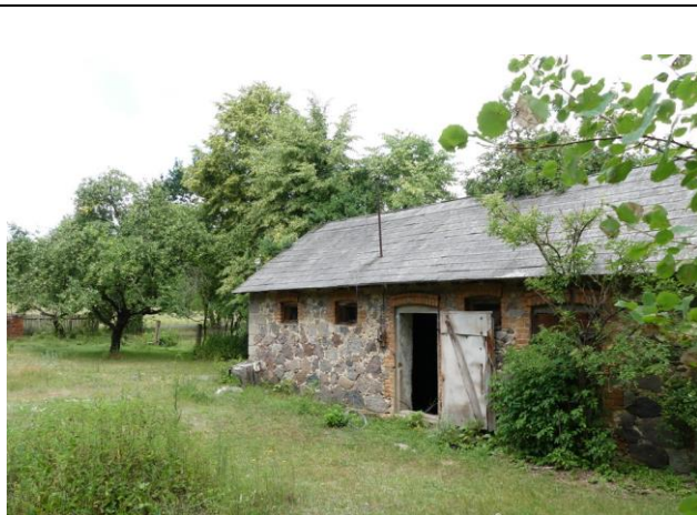
Fot. 44. Stefanów. Opuszczone gospodarstwo. Dobrze zachowany dawny budynek. St. nr 11, Ryc. 8.
