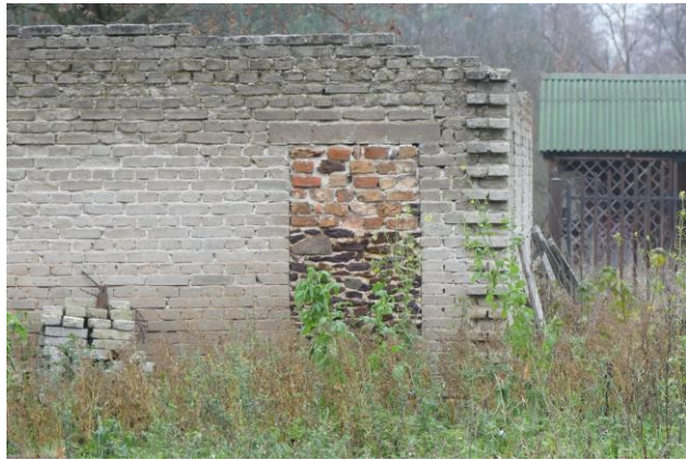
Fot. 15. Niespotykany na południowym Mazowszu przypadek wykorzystania do lokalnego budownictwa miejscowych rud żelaza. St. nr 2, Ryc. 3.
