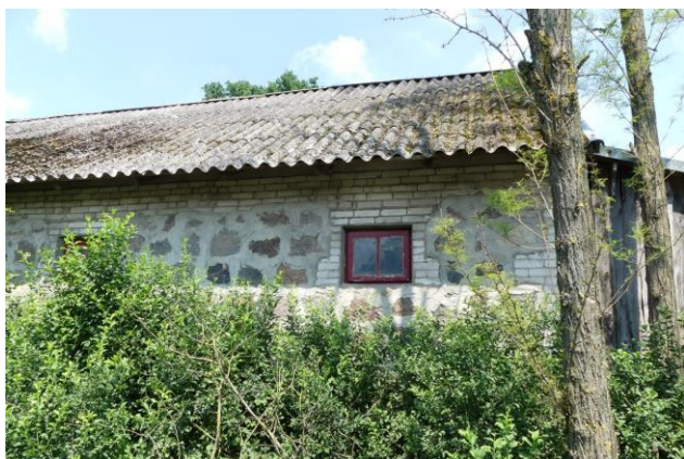
Fot. 14. Użycie do budowy budynku gospodarczego lokalnych kamieni polnych naniesionych przez lodowiec. St. nr 3, Ryc. 3.
