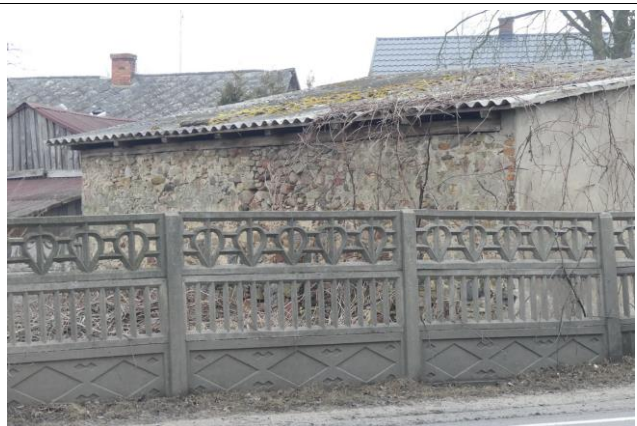
Fot. 7 Bardzo ładny, stary budynek gospodarczy na tzw. "Migówce" koło klasztoru. Lokalny ochrowy piaskowiec w mieszance z granitami polodowcowymi. Konieczna renowacja i wyeksponowanie. St. nr 2. Ryc. 2.
