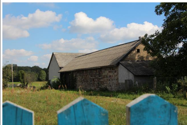
Fot. 19. Bardzo ładny układ wielu materiałów użytych do budowy miejscowej obory - głązy i kamienie polodowcowe, piaskowiec miejscowy, cegła. Małoszyce. St. nr 3, Ryc. 4.
