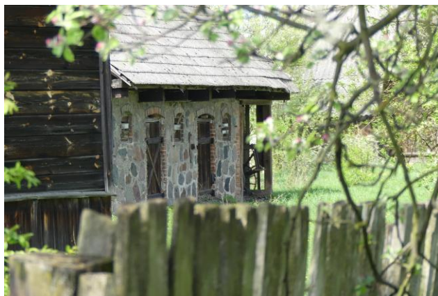
Fot. 57. Użycie w lokalnym budownictwie kamieni polnych (polodowcowych)
