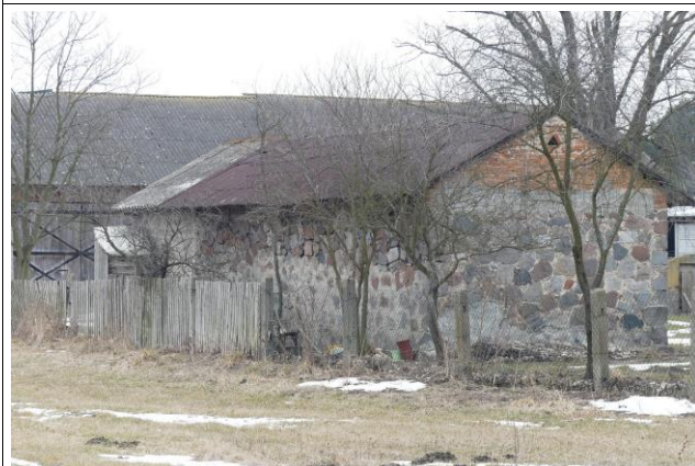
Fot. 54. Brudzewice - budynek gospodarczy, obiekt nr 16, Ryc. 9.
