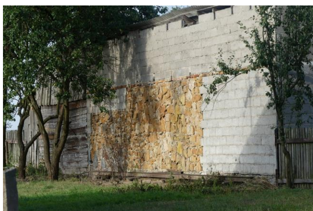
Fot. 59. Przykład wykorzystania miejscowego piaskowca żelazistego.
