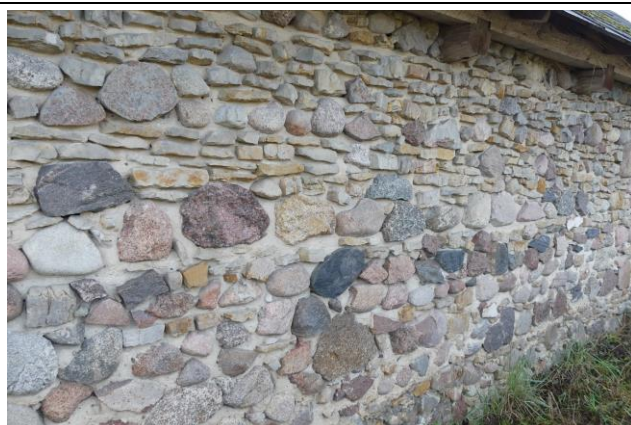
Fot. 34. Bardzo ładna obórka z lokalnie kopanego piaskowca z domieszką kamieni polnych. Poręby. St. 8, Ryc. 6.
