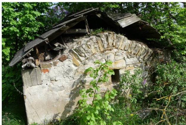
Fot. 61. Opuszczone gospodarstwo - piwniczka z mieszanki piaskowców. St. nr 4, Ryc. 12.
